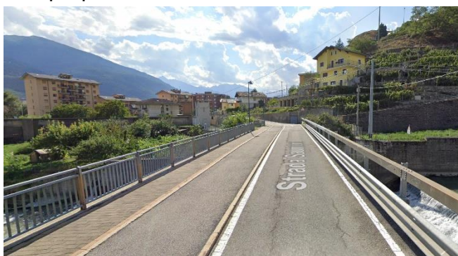
Strada Saumont (fonte: Google Street View)
