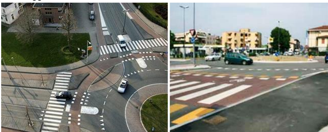
Percorso ciclabile esterno alla rotonda con attraversamento rialzato; (fonte: “Quaderni del Centro Studi FIAB Riccardo Gallimbeni”)
