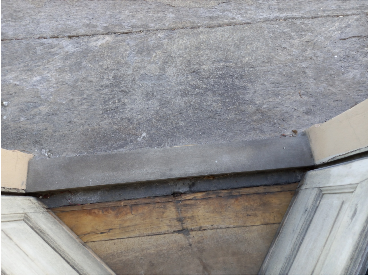
Fotografia n° 24: Particolare soglia in malta serramento PF5.
