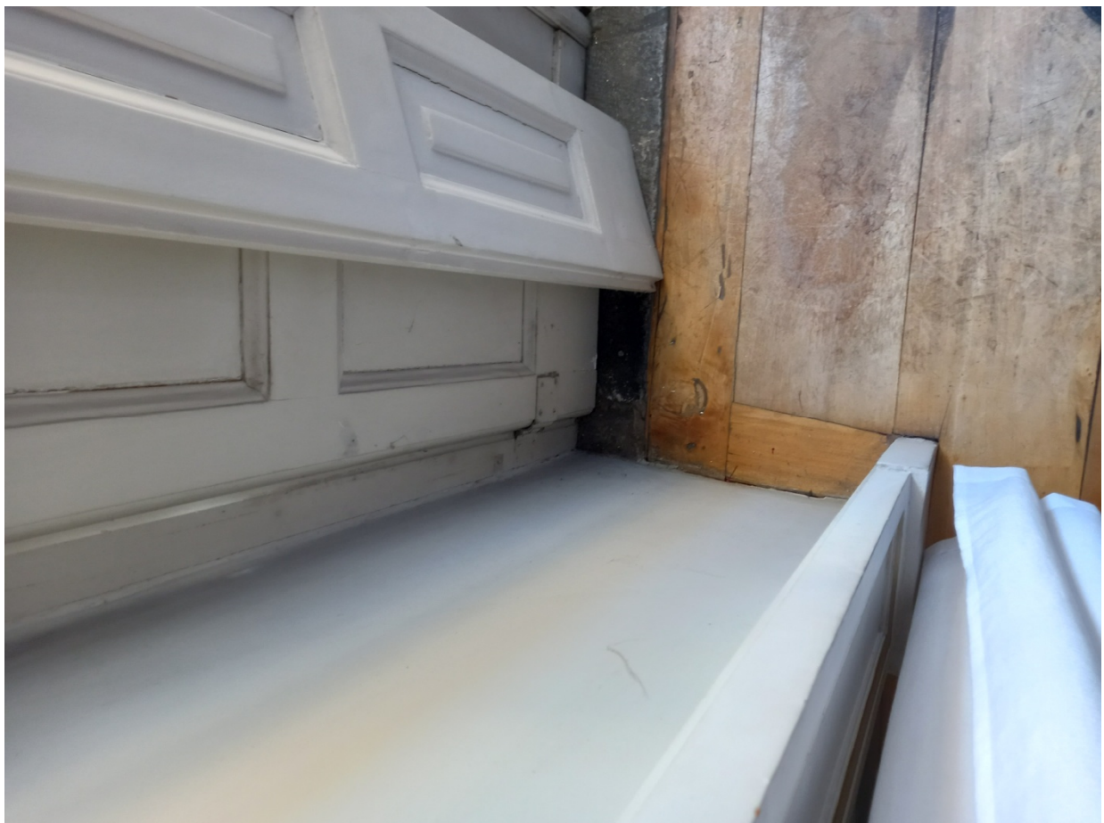
Fotografia n° 27: Particolare ante oscuranti interne serramento PF6.
