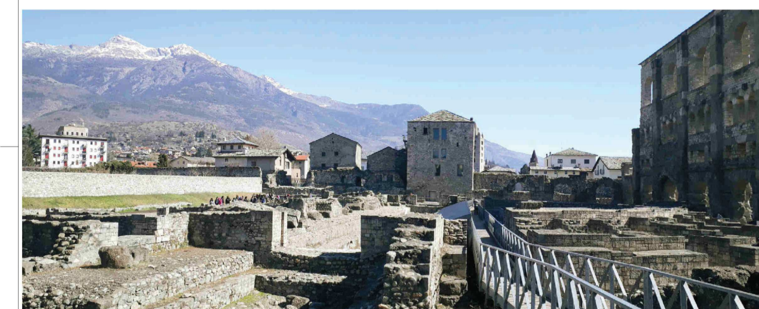
TR3 - Vista dal lato est
