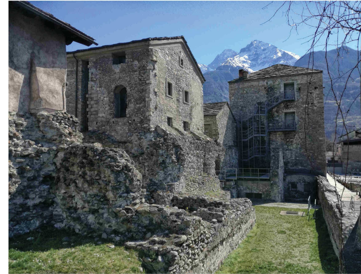
TF2 - Lato nord tour fromage
