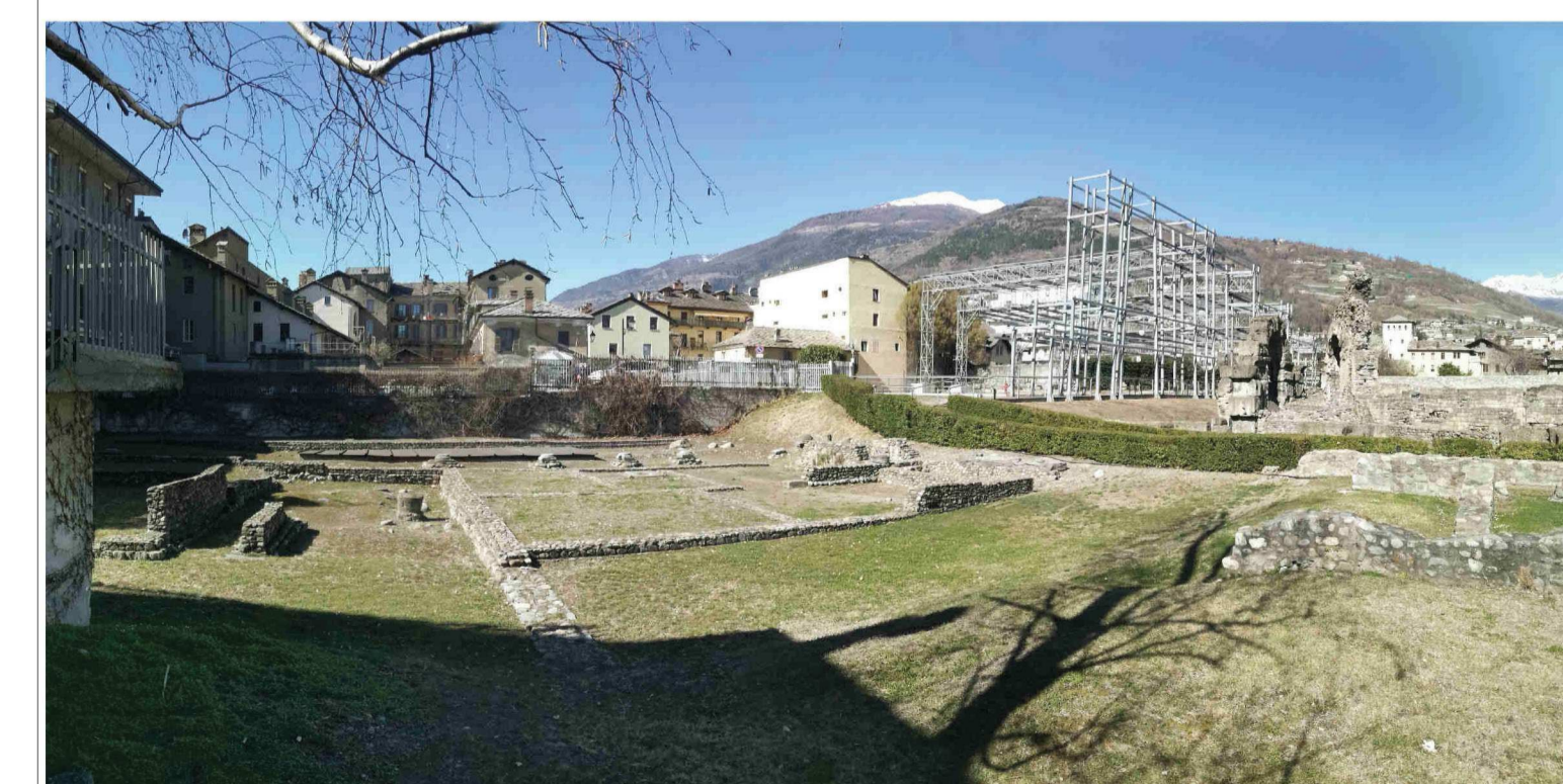
AO1 - Vista dal lato sud
