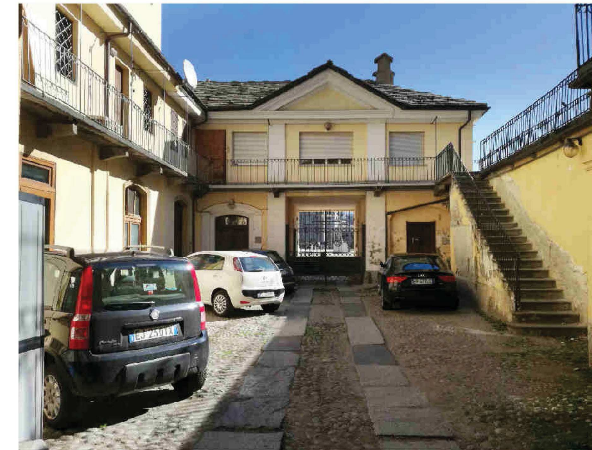
LF2 - Vista dalla corte interna
