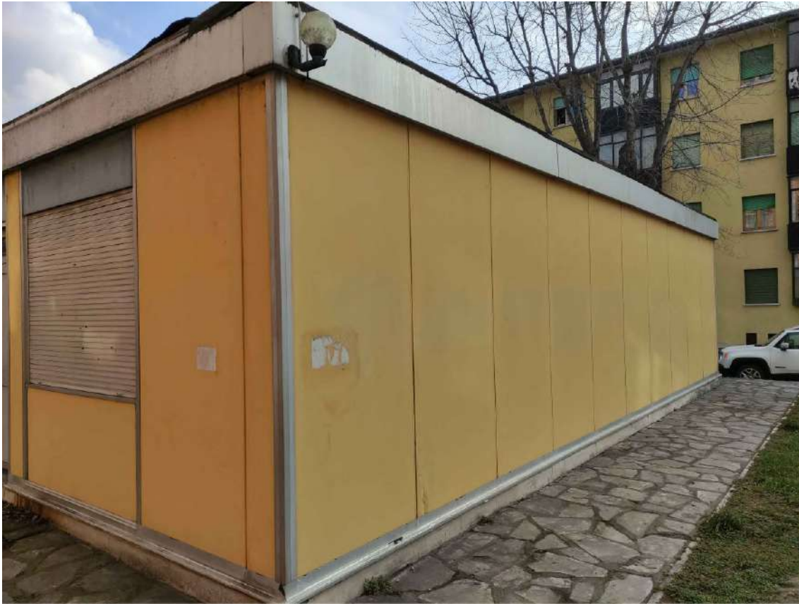
9 - Particolare elementi prefabbricati di tamponamento
