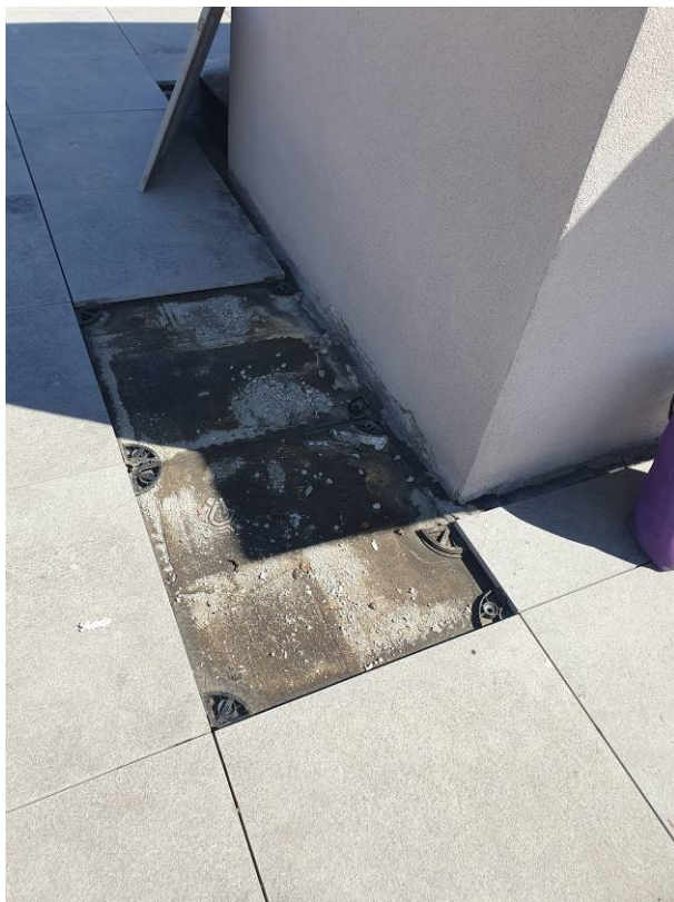
PARTICOLARE INSTALLAZIONE PIASTRELLE TERRAZZA
