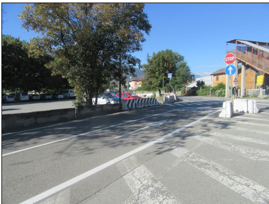
FOTO 32 VISTA FOTOGRAFICA VIA VALLI VALDOSTANE INCROCIO STRADALE REGOLATO DA STOP CON AREA SPARTITRAFFICO ZEBRATA E POSA DI NEW JERSEY
