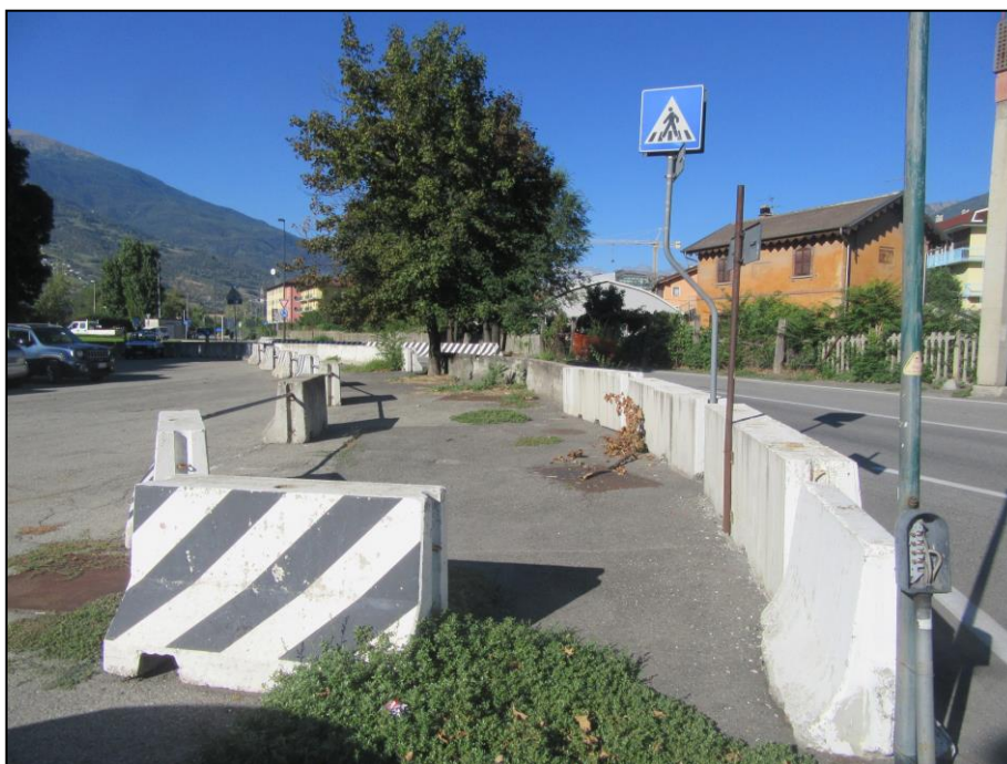
FOTO 44 VISTA FOTOGRAFICA VIA VALLI VALDOSTANE TRATTO CON DOPPIA FILA DI NEW JERSEY PER SEPARAZIONE CARREGGIATA E DELIMITAZIONE AREA PARCHEGGIO
