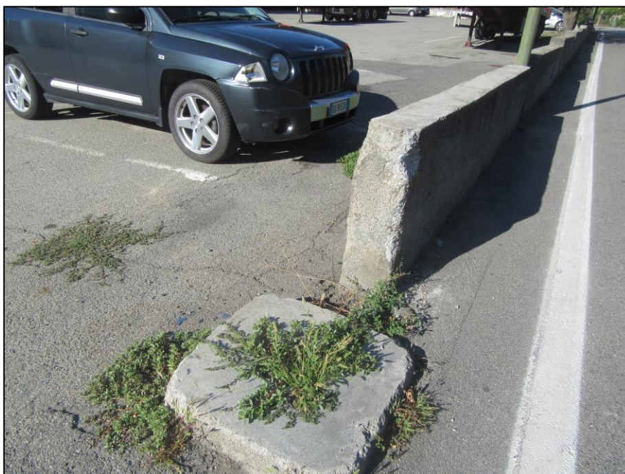
FOTO 28 VISTA FOTOGRAFICA VIA VALLI VALDOSTANE MURETTO IN CLS DI SEPARAZIONE TRA LA CARREGGIATA E L'AREA ASFALTATA DESTINATA A PARCHEGGIO
