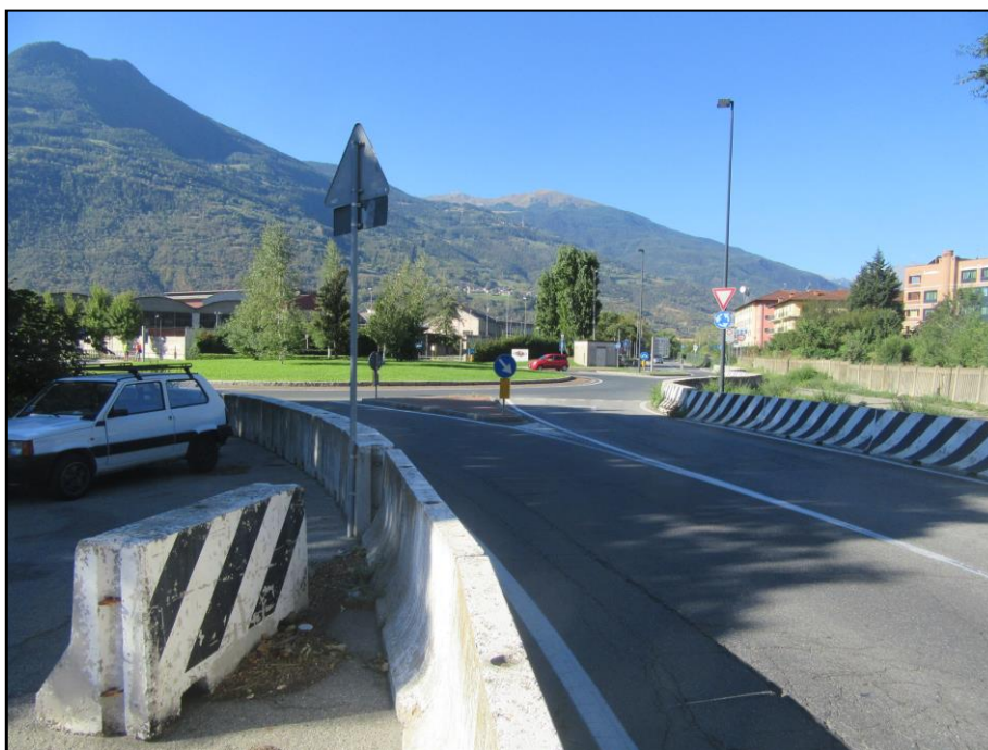
FOTO 46 VISTA FOTOGRAFICA VIA VALLI VALDOSTANE INCROCIO REGOLATO DA ROTATORIA CON NEW JERSEY PER DELIMITAZIONE CARREGGIATA
