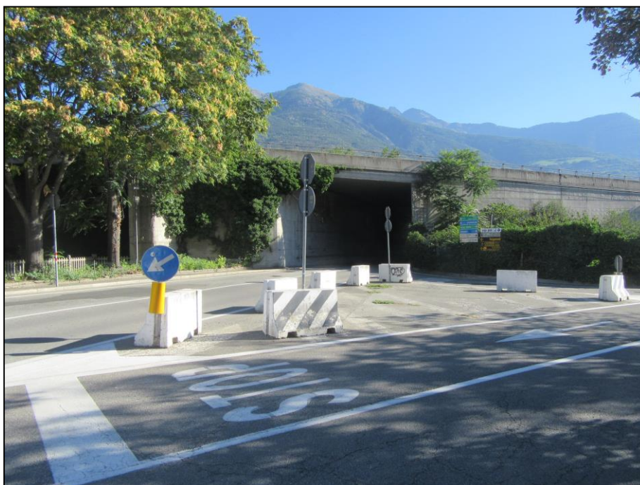
FOTO 42 VISTA FOTOGRAFICA VIA VALLI VALDOSTANE INCROCIO STRADALE REGOLATO DA STO CON AREA SPARTITRAFFICO ZEBRATA E POSA DI NEW JERSEY
