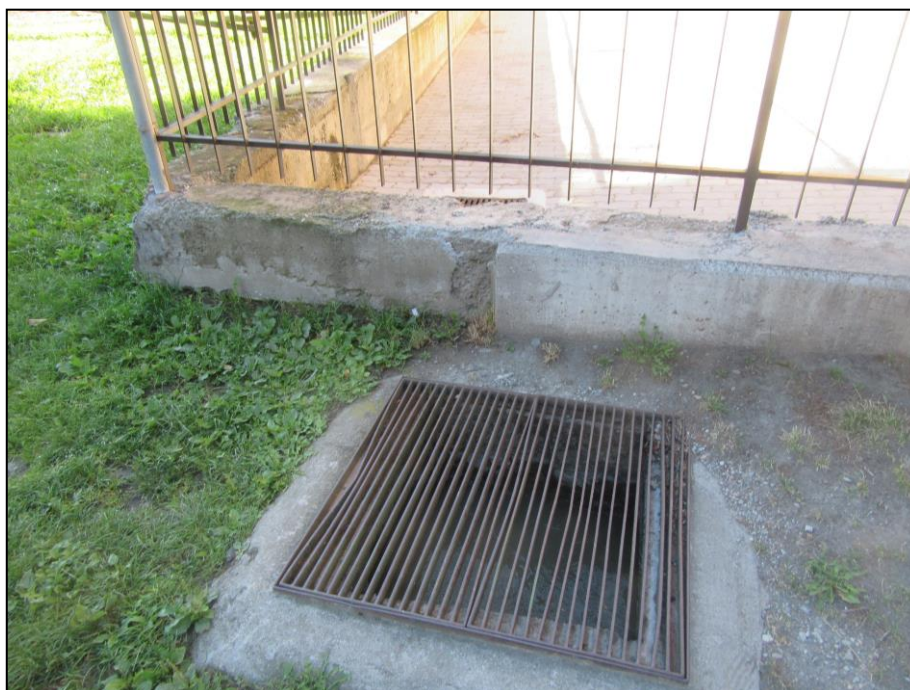
FOTO 14 VISTA FOTOGRAFICA VIA VALLI VALDOSTANE POZZETTO GRIGLIATO DI DIRAMAZIONE PER CANALE IRRIGUO
