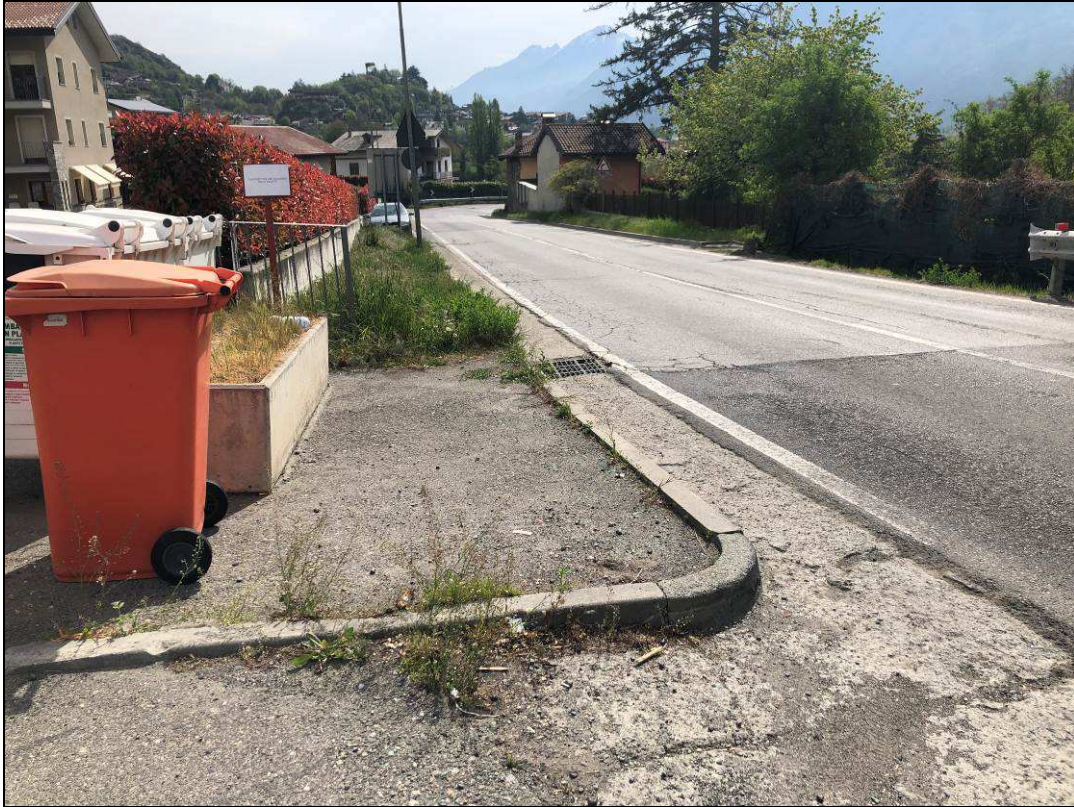
1. Rettilineo all'inizio dell'intervento; accessi n. 7 e 8
