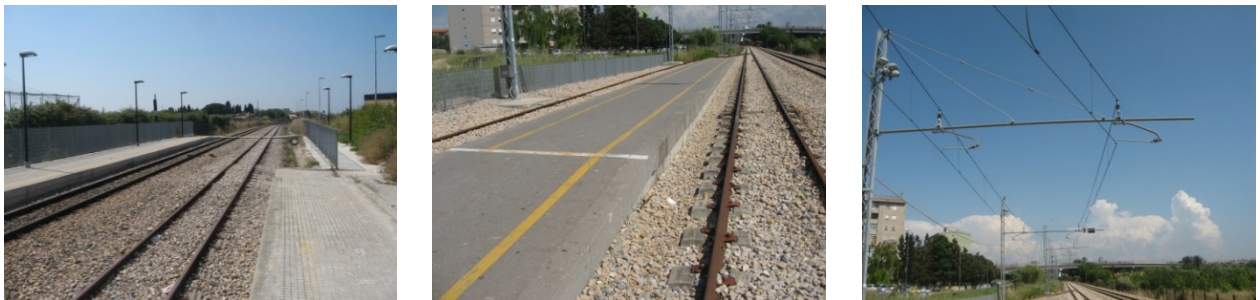
Metrotranvia di Sassari: i binari, i marciapiedi di stazione e l'elettrificazione
