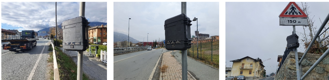
Montaggio delle apparecchiature Radar ad Aosta (Sezioni da sinistra a destra S04, S11 e S03)
