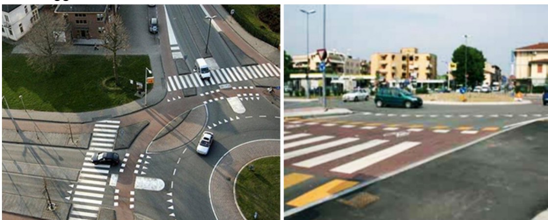
Percorso ciclabile esterno alla rotatoria con attraversamento rialzato; (fonte: “Quaderni del Centro Studi FIAB Riccardo Gallimbeni”)
