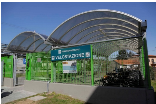
La velostazione di Ferrovienord a Castano Primo
