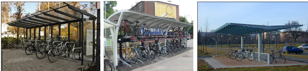
Esempio di sosta con copertura
