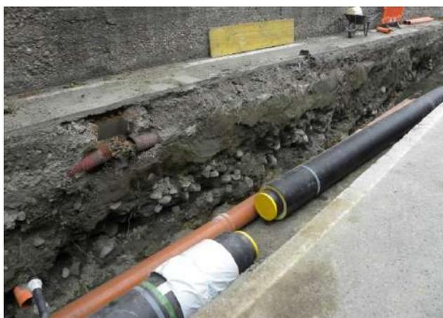
**Figura 19:** Il muro in ciottoli e malta trovato nel lavoro del teleriscaldamento del 2014 su via Garibaldi.
